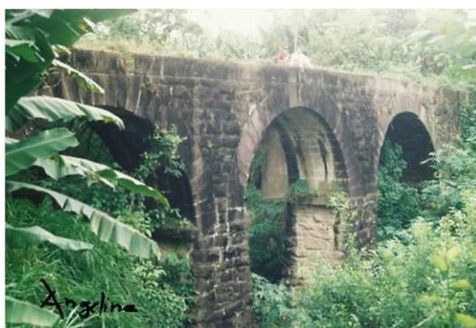
Ponte ferroviária sobre o Ribeirão do Tigre, próxima da estação de Itoupava Seca; ainda existe mas está abandonada. Foto Angelina Wittman, 2013.
