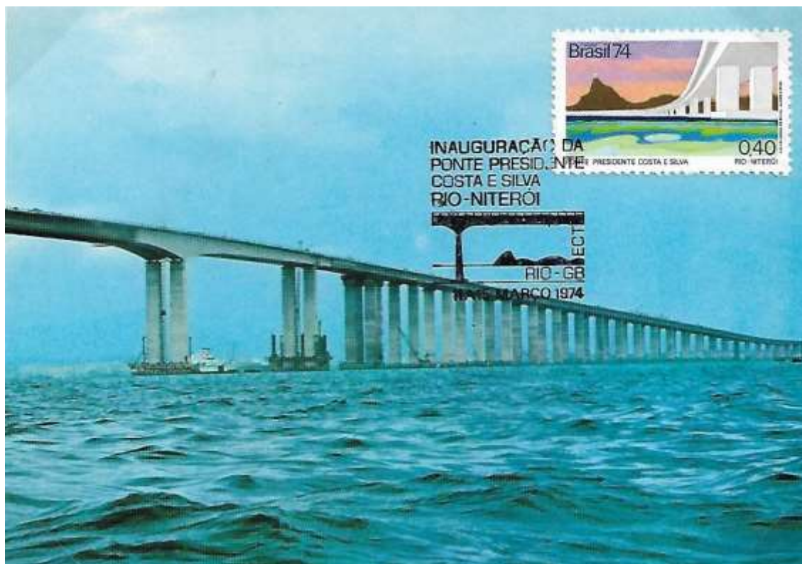
Ponte Presidente Costa e Silva (Ponte Rio-Niterói), Rio de Janeiro-Niterói/RJ - Emissão: 11/03/1974 - Postal: Ed. Brasilcolor 57 - Obliteração comemorativa: Rio de Janeiro/RJ - 11 a 15/03/1974
